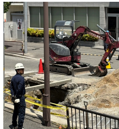
5月10日の公共下水道に起因する道路陥没事故の復旧工事
